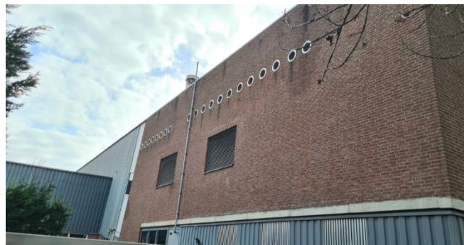
Figuur 5: Noordelijke hoek sportaccommodatie
