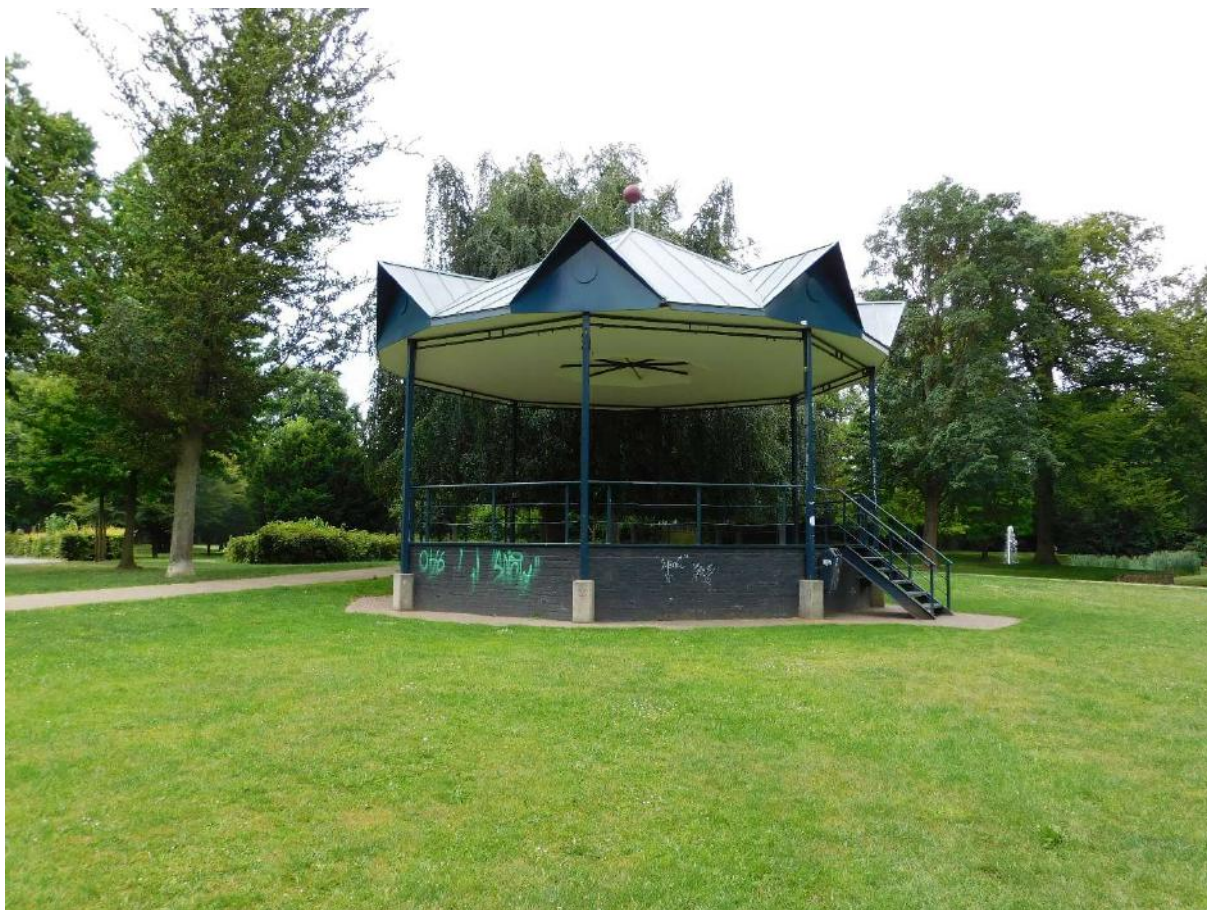
Figuur 12 - De Kiosk in het Burgemeester Damenpark. Het betreft een reconstructie in de trant van de oude kiosk.
