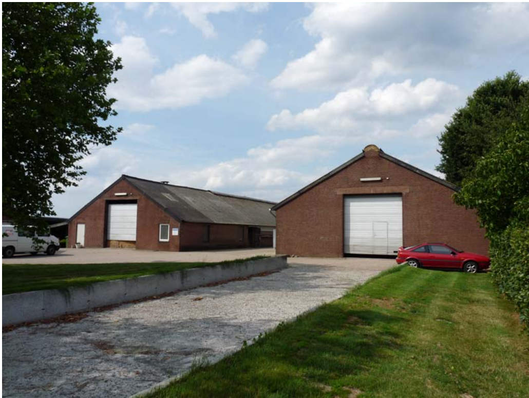
Foto 1. Vooraanzicht te slopen koeienstallen
