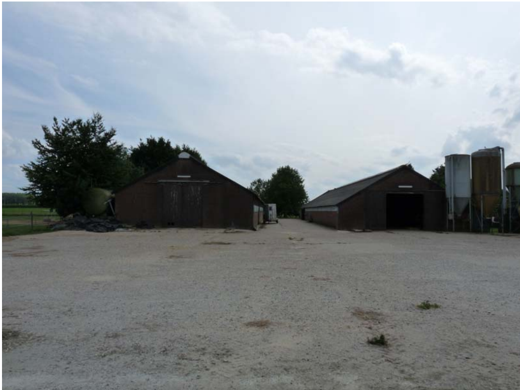
Foto 3. Achteraanzicht te slopen koeienstallen
