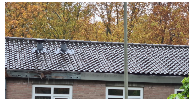
Figuur 10: Dakrand van uitbouw aan Mauritspark 1A
