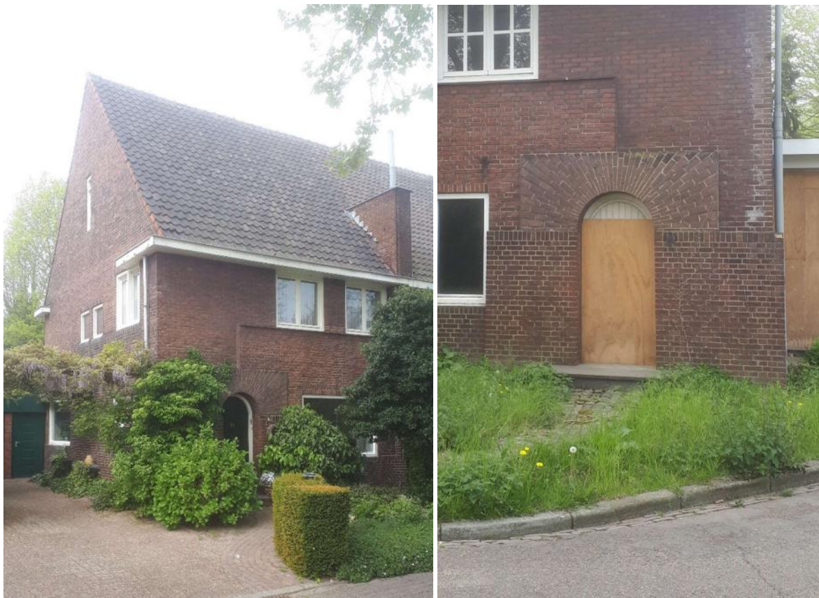
Figuur 10 Dubbele beamttenwoning Mauritspark naar ontwerp van het bureau Staatsmijnen in Limburg; links overzicht, rechts detail van het siermetselwerk.
