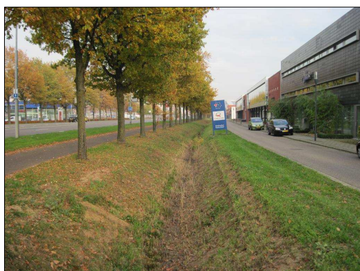
Afbeelding 17. De groenstrook met afwateringssloot langs de Bergerweg.
