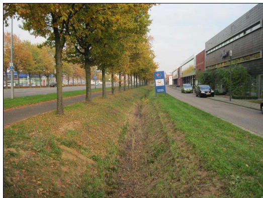
Afbeelding 17. De groenstrook met afwateringssloot langs de Bergerweg.
