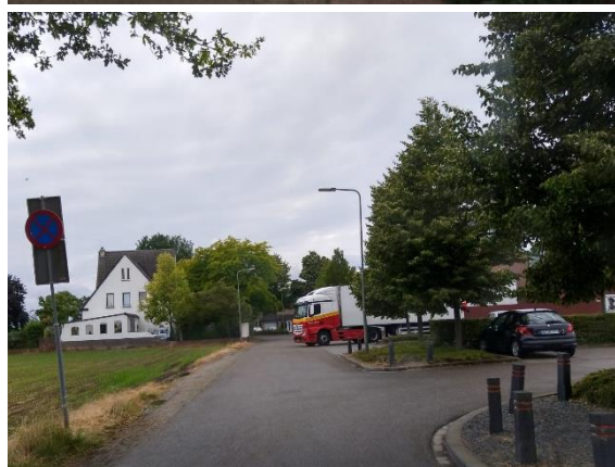
Figuur 15: wegprofiel Frankenstraat met bermschade en laden/lossen
