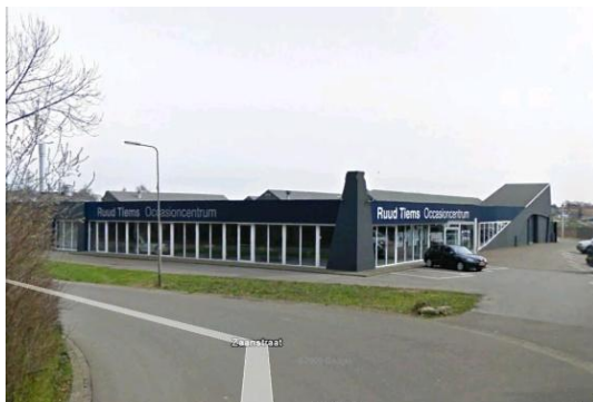
Bedrijfsbebouwing vanaf Zaanstraat
