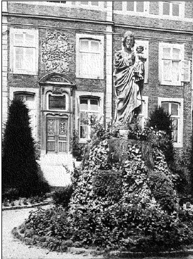
Het voormalige St. Josephbeeld aan de voorzijde van het kloostergebouw
