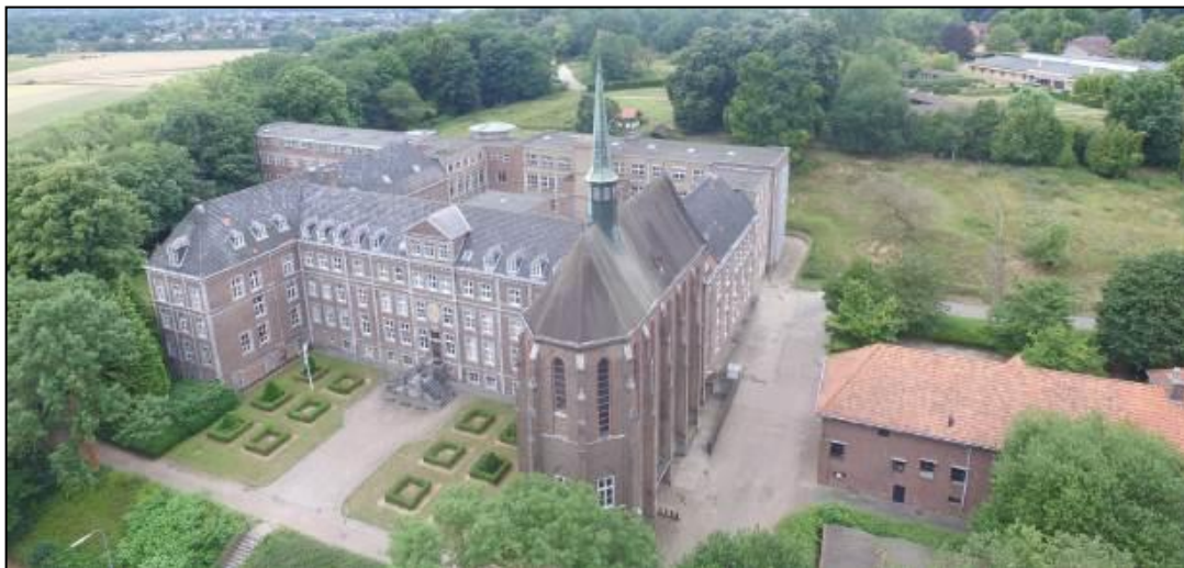
De bestaande bebouwing in deelgebied 6 (het voormalige kloostergebouw)
