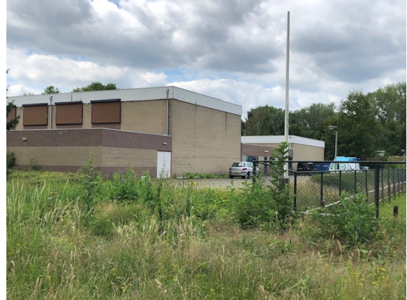
Figuur 5 Krachtsportcentrum en klein binnenzwembad, gebouw 3.1 op de overzichtskaart
