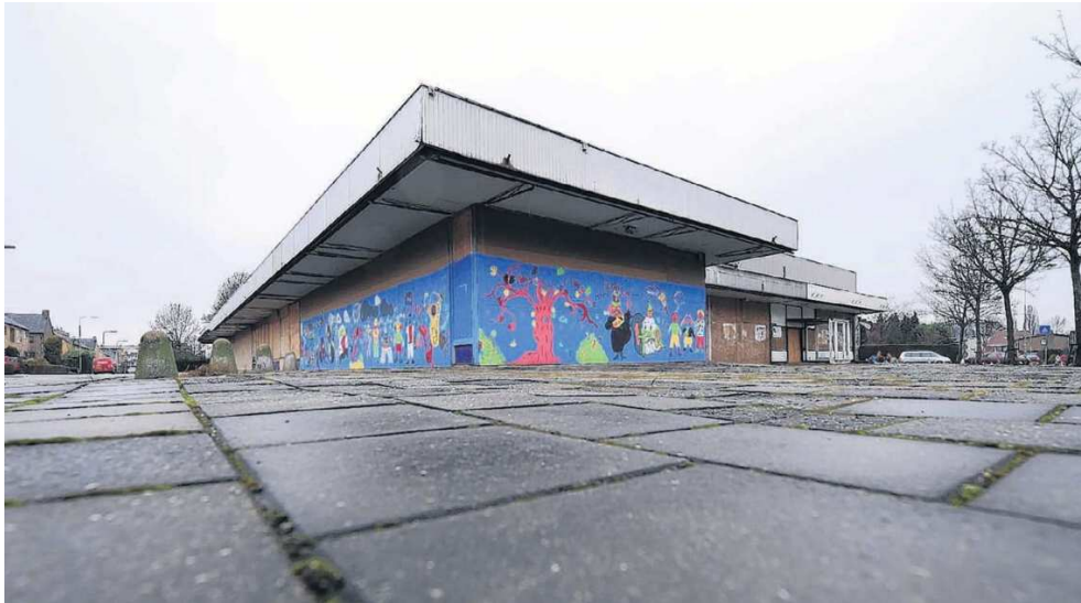
Foto bestaande situatie leegstaande winkelcentrum
