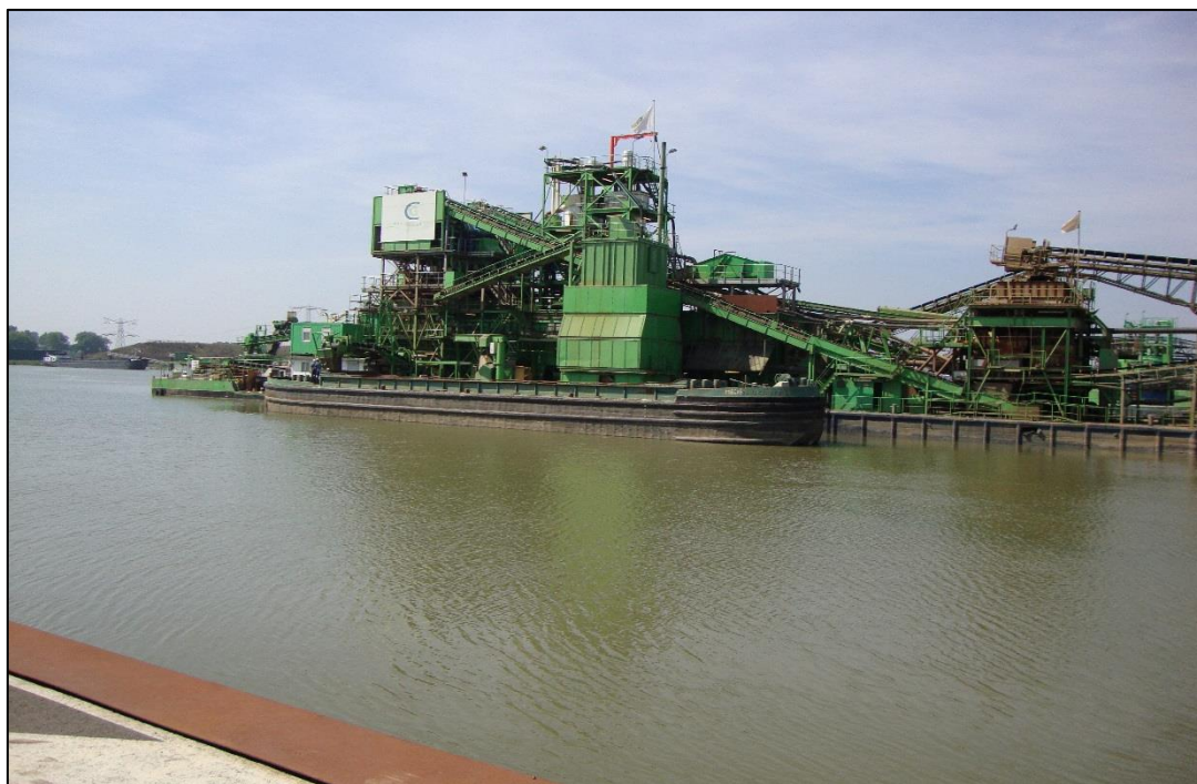
De grindinstallaties ter plaatse van het plangebied, met op de voorgrond de werkhaven
