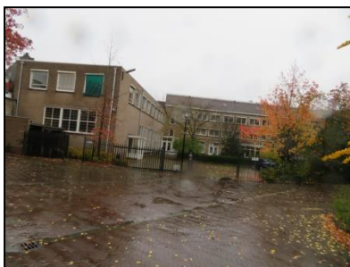
Figuur 3. Aanbouw westzijde bestaande uit appartementen.
