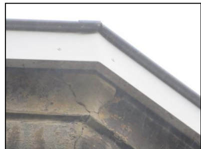
Figuur 13. Openingen aanwezig in de kapel.
