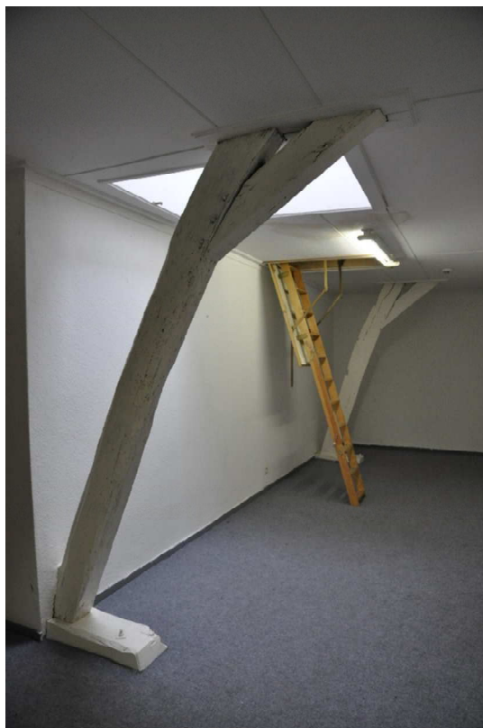
61 de onderste spantbenen van de kapspanten
