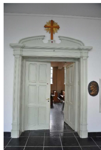
79 toegangsdeur naar de kerk
