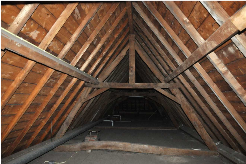
63 de kapconstructie op vlieringniveau met de bovenste jukken en het nokstijlgebint.
