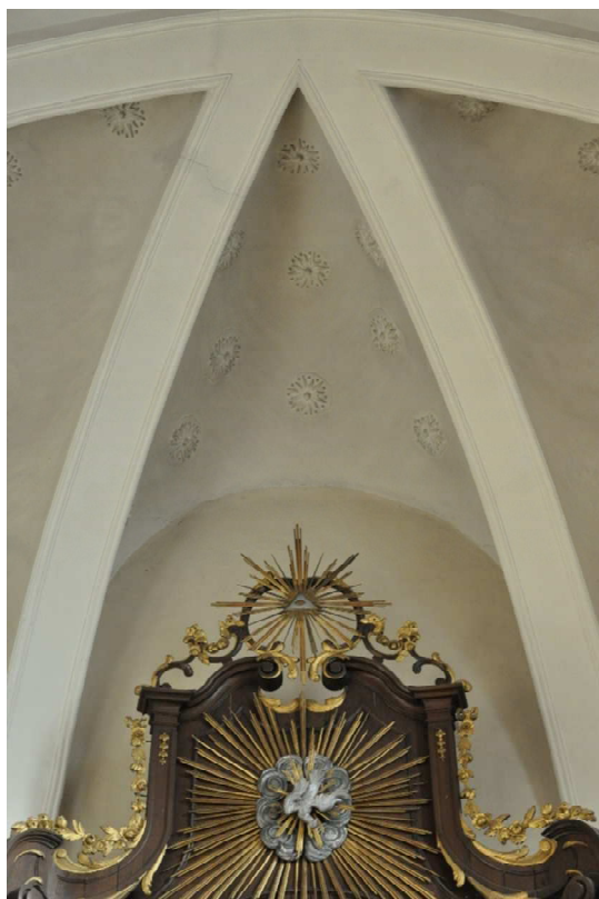
47 detail van het stucwerk boven het hoofdaltaar
