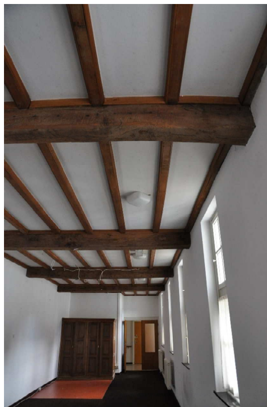
77 de eiken balklaag op de verdieping
