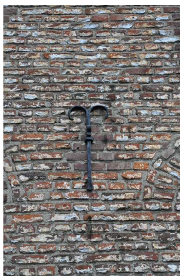
58 detail van een balkanker
