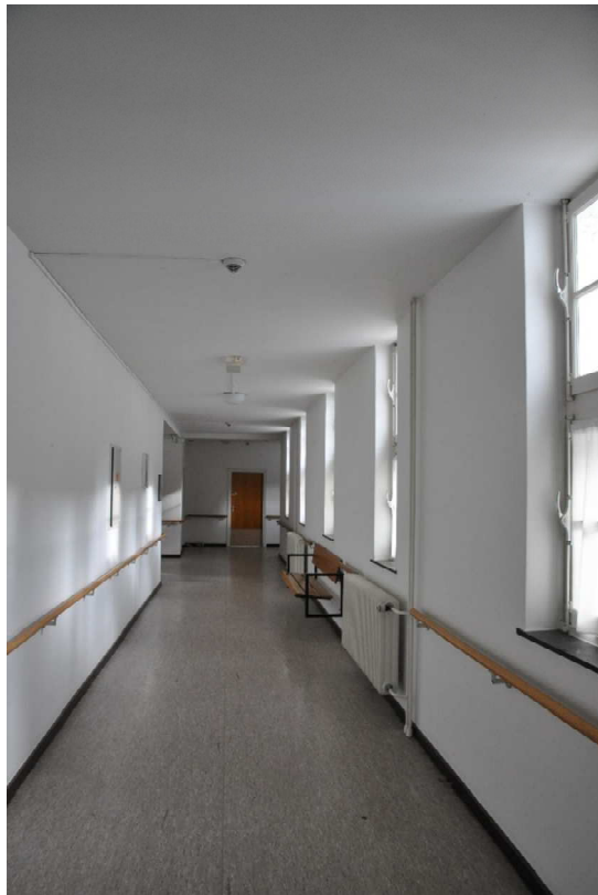
66 de gang op de verdieping, richting het noordoosten
