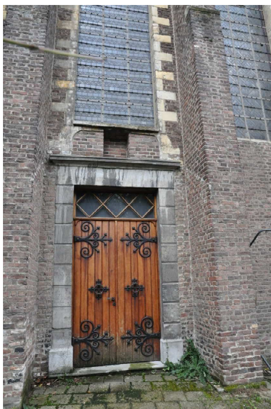
36 de toegang in de zuidoostelijke gevel.
