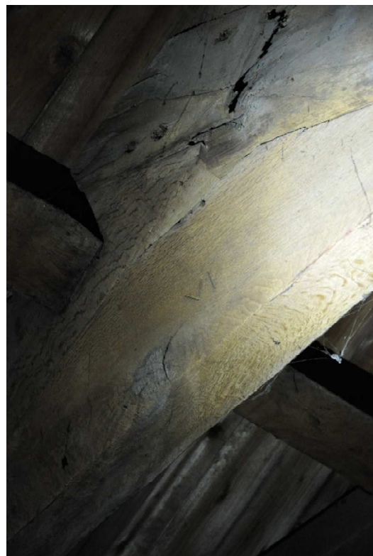
54 detail van een gekapt telmerk 'VI' (6) op een spant.
