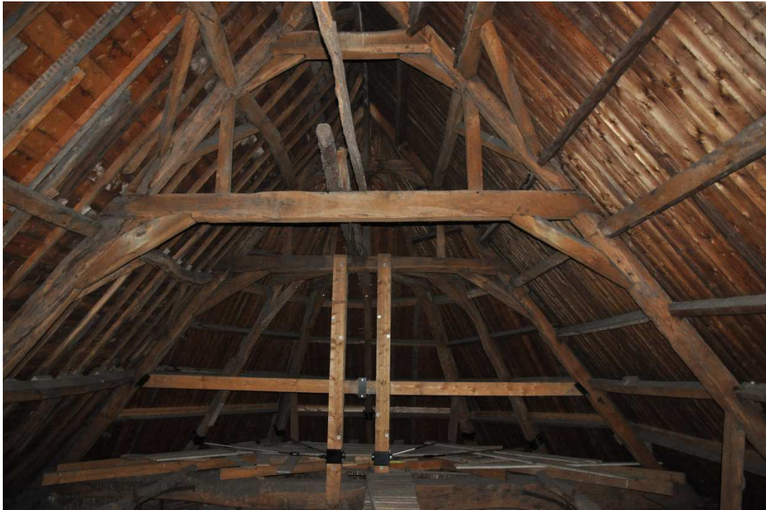
51 de kapconstructie van de kerk, gezien naar de koorsluiting.
