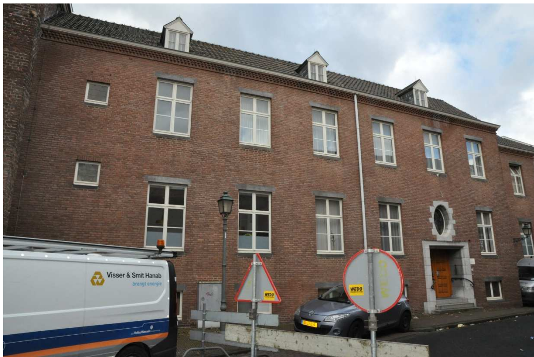
68 de straatgevel van de noordelijke vleugel uit 1965
