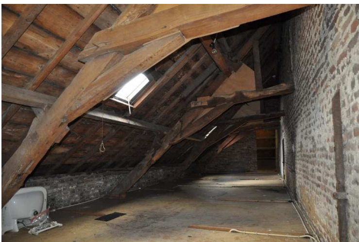
78 de kapconstructie met halve eiken spanten
