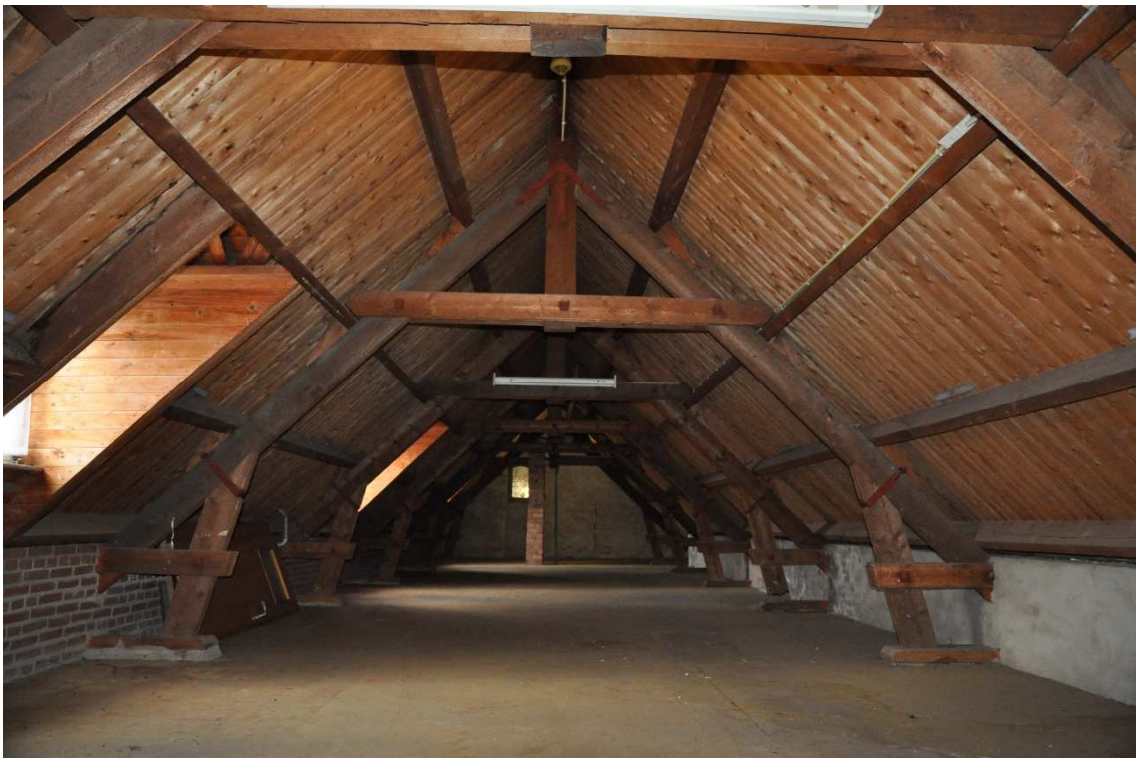
74 de kapconstructie van de noordelijke vleugel uit 1965, gezien richting de kerk.
