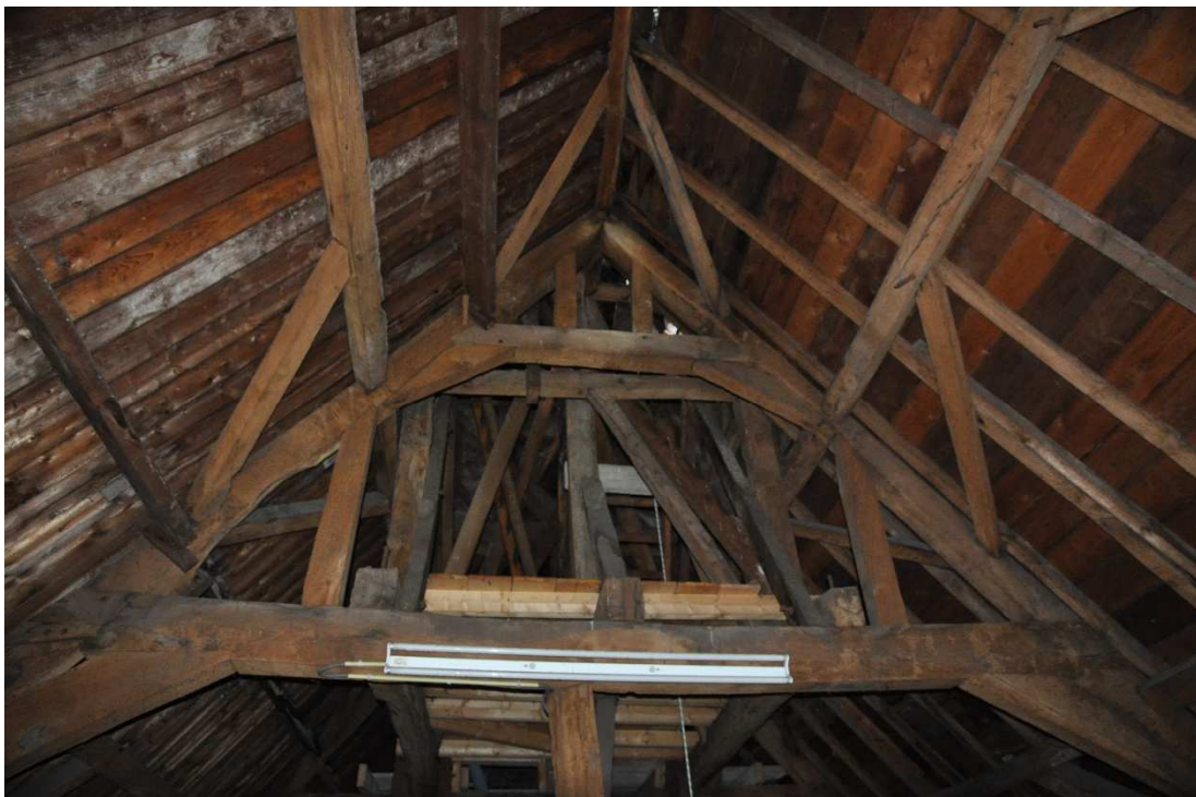
52 detail van een kapsant met daarachter de draagconstructie van de dakruiter.
