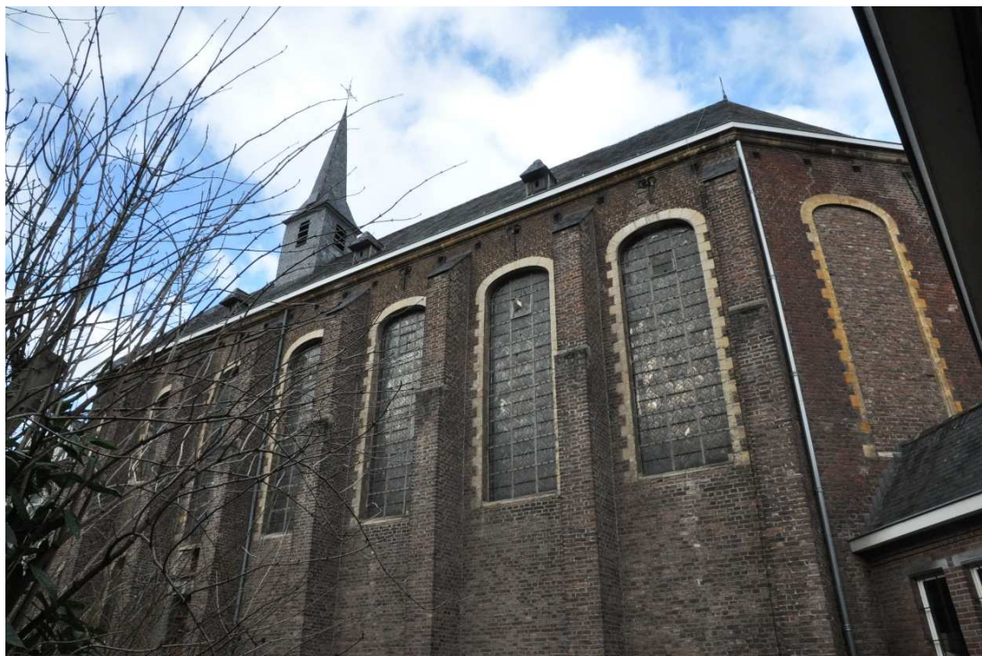
35 de zuidoostelijke gevel van de kerk.
