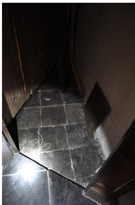
50 de oude hardstenen vloer ligt onder de huidige vloer, ter plekke van het noordelijke zijaltaar.
