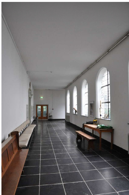
76 de kloostergang op de begane grond
