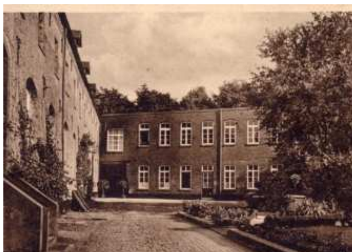
25 de school (later strijkinrichting) langs de wal ná de verbouwing van 1922, waarbij een verdieping met plat dak werd toegevoegd.
