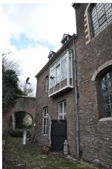
57 de zuidoostelijke kopgevel met erker
