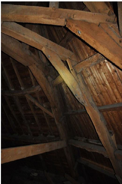
53 detail van de halve jukken in de koorsluiting.
