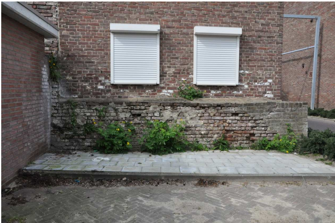
85 het lage muurdeel is het restant van de voormalige kloostermuur, opgetrokken in handgevormde steen
