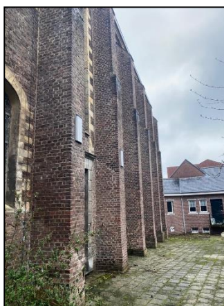
Figuur 13. Voorbeeld van opgehangen kasten aan zuidgevel klooster.
