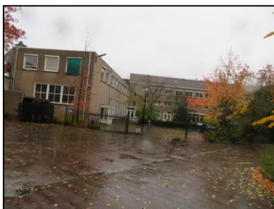
Figuur 3. Aanbouw westzijde bestaande uit appartementen.
