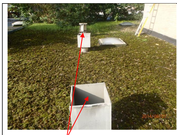
Foto 12: Afzuigventilatoren verwijderd
