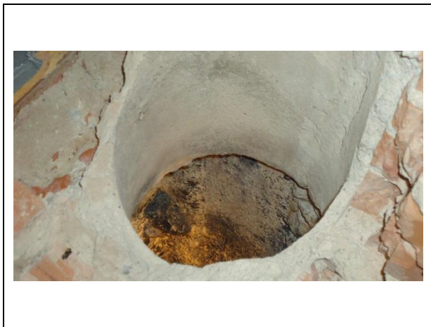
Foto 7: Doorvoer naar kelder is schoon.
