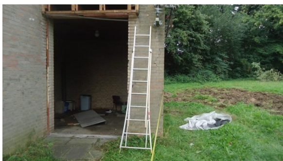
Foto 3: Toegang dak via ladder.
