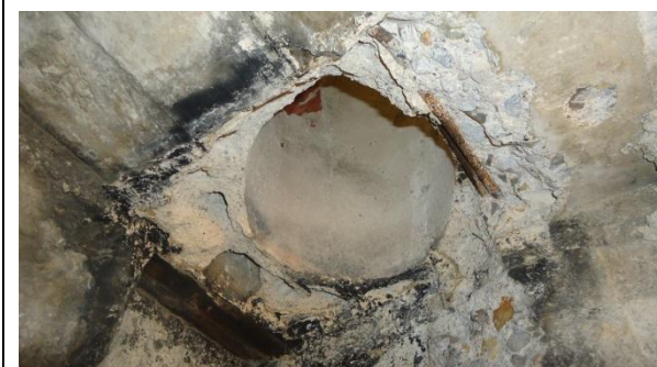
Foto 3: Doorvoer bg. Is schoon.
