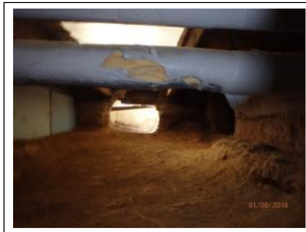
Foto 12: Gereinigd zandbed onder houten vloer lokaal 5
