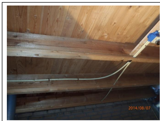
Foto 10: Plafondbeplating verwijderd
