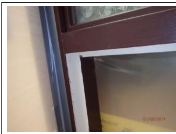
Foto 6: Plaats gesaneerde puivulling
