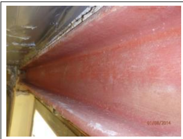
Foto 7: Plaats gesaneerde balkbekleding
