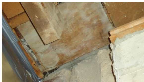
Foto 6: 1 e etage afgeschermd met houten plaatmateriaal.
