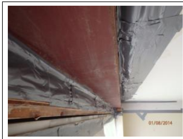
Foto 8: Plaats gesaneerde balkbekleding
