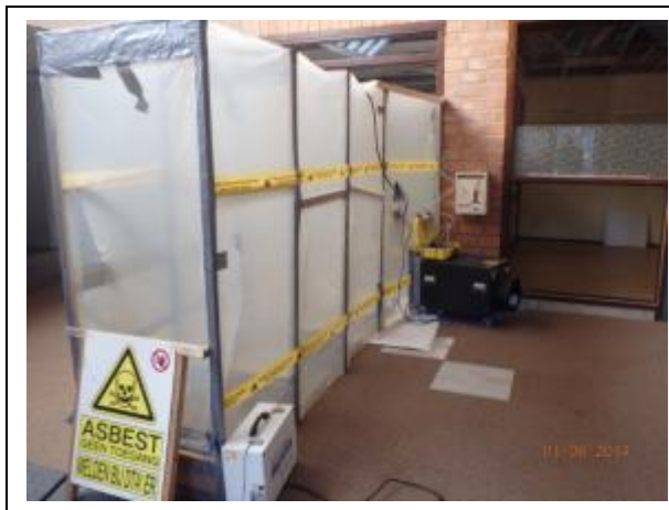
Foto 2: Transitsluis in gang opgesteld
