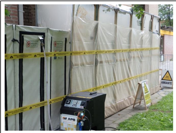
Foto 1: Overzicht containment buiten
