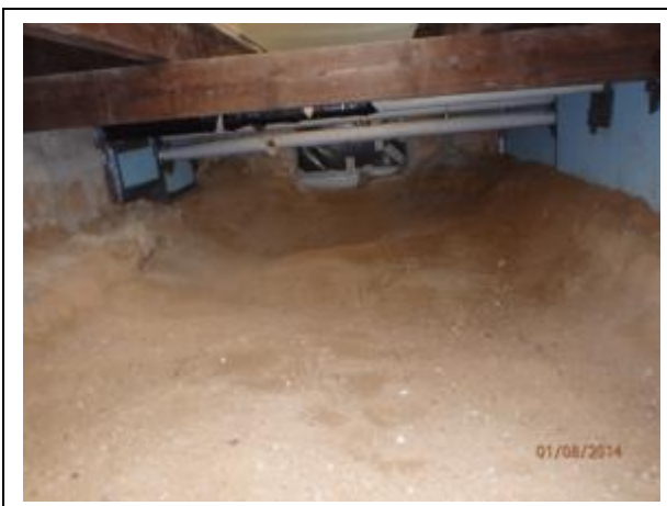
Foto 9: Gereinigd zandbed onder houten vloer lokaal 5
