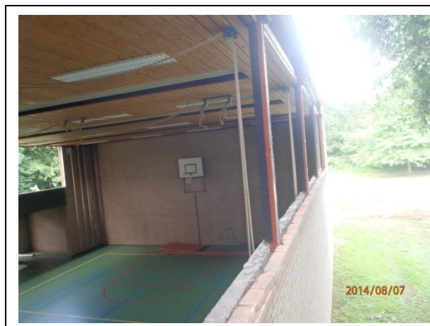
Foto 4: Kozijnen en katten verwijderd
