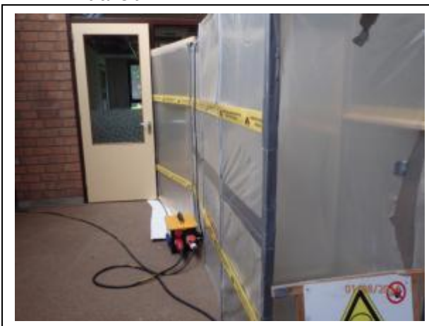
Foto 3: Containment en transitsluis
