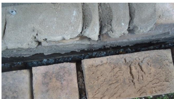
Foto 5: Spouwmuur beperkt inspecteerbaar.
