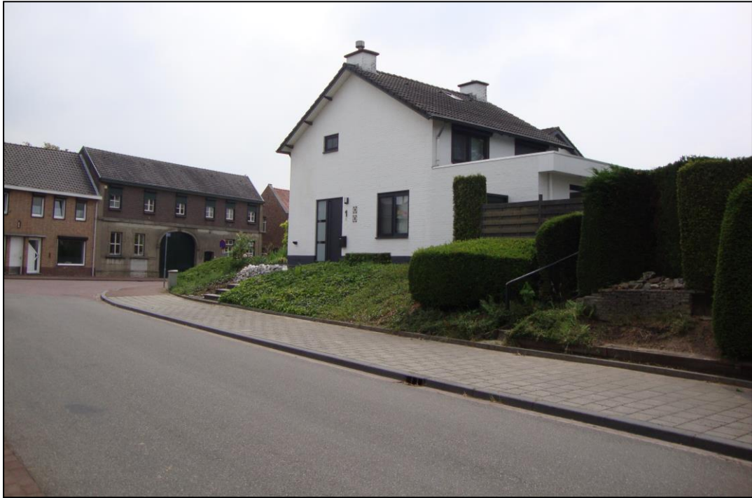
Woning Rijstraat 1, grenzend aan deelgebied 3
