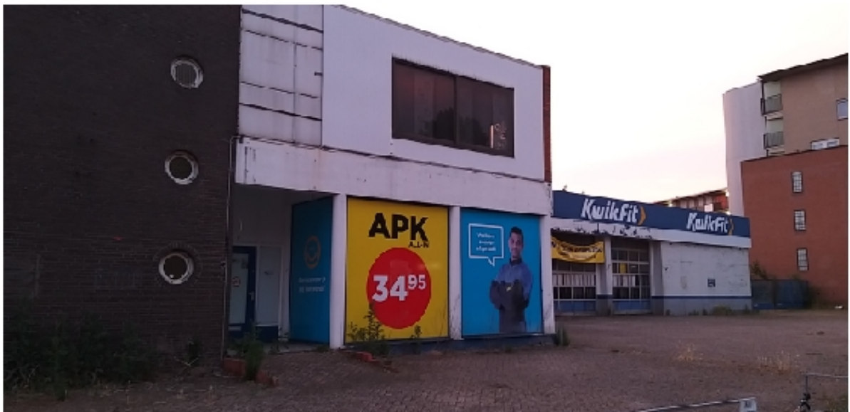
Foto 4: Voorzijde gebouw (vanaf de weg gezien)
