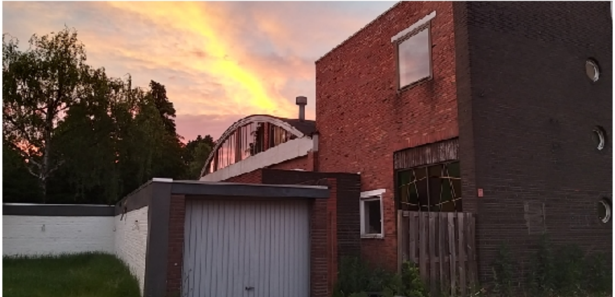
Foto 2: Linkerzijde gebouw (vanaf de weg gezien), met stenen muren
