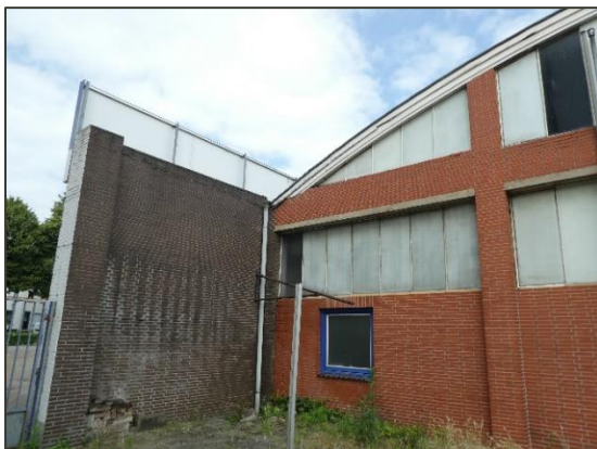
Afbeelding 8 Zijkant van het garagegebouw.
