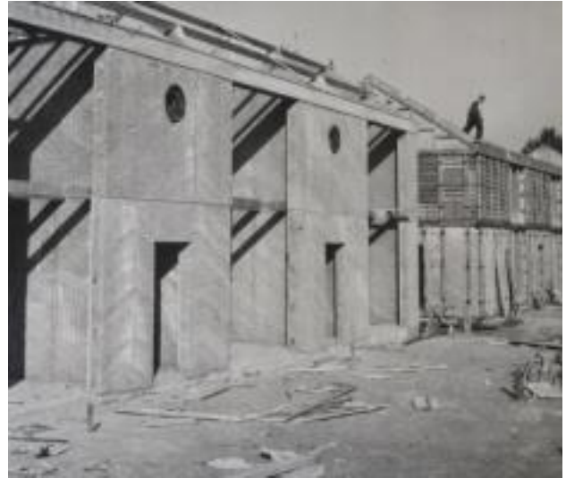
De in aanbouw zijnde (100) betonkorrel woningen, die in het werk werden gestort. (bron EHC Sittard)
