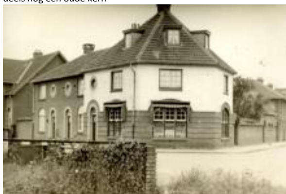
Historische foto eerste deel sociale woningbouw (1919 Stuyt)
