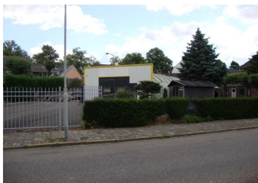
Dakdekkersbedrijf (Verlengde Heinseweg)
