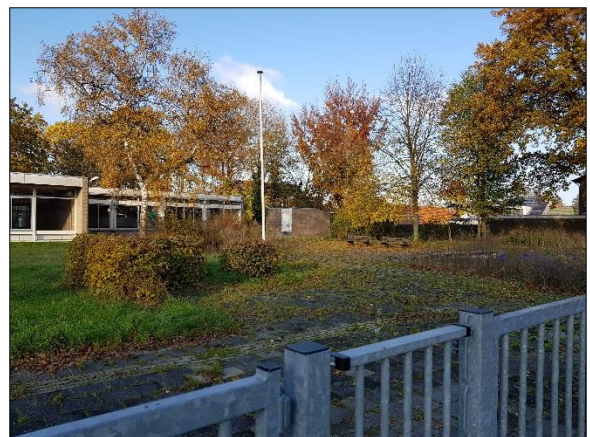
Figuur 9. Groen op het plein aan de zuidelijke kant gezien vanaf Munnikstraat
