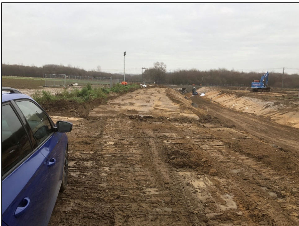
Figuur 2.4: Bouwwerkzaamheden bij de spoorbrug aan de zuidzijde van het plangebied
