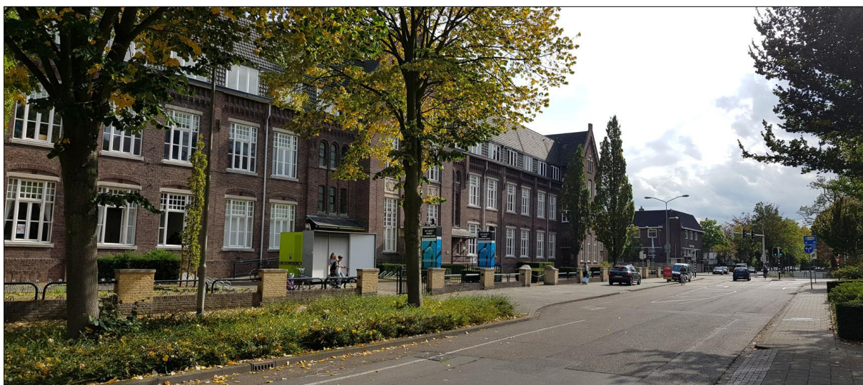
Voorzijde van 't Kleesj, gezien vanaf de hoek Parklaan – De Wieër.
