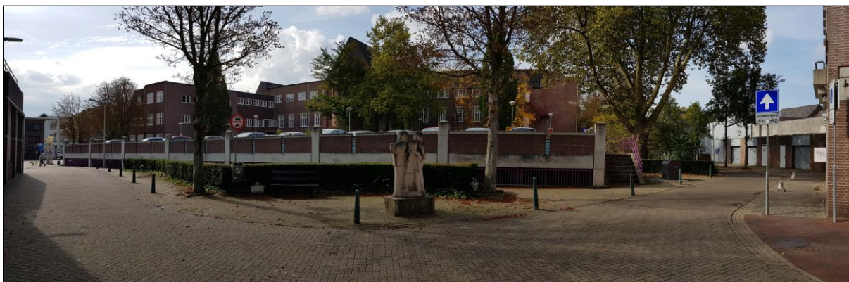
Zicht op de achterzijde van parkeergarage De Wieër en de achterzijde van 't Kleesj, gezien vanaf De Wieër.
