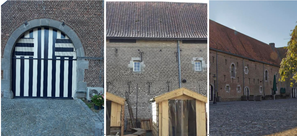
Figuur 2 - Links: aanzicht van de gevel met toe- en afvoerroosters (1x1 m) boven brouwerij. Midden en rechts: toe- en afvoerroosters (2x0,25 m) t.b.v. linker vleugel
