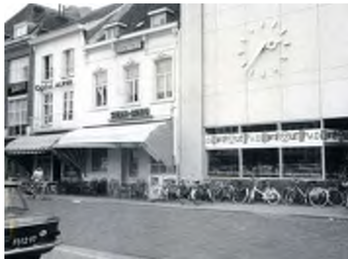
Pand links van V&D afgebroken en gevel naatsgelegen pand wit geschilderd (bron: Archief De Domeinen, identificatienummer 713_061_262).
