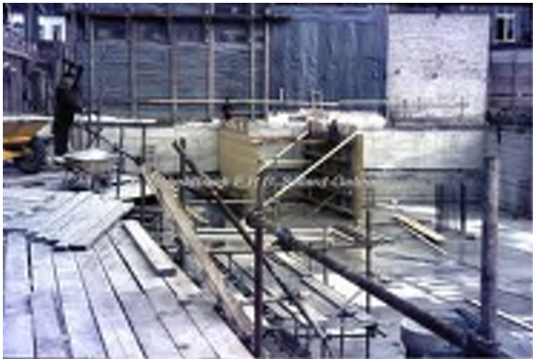
Bouwwerkzaamheden aan de nieuwbouw van Vroom en Dreesmann op de Markt te Sittard (bron: Archief De Domijnen, Collectie Gemeente Sittard, bestandsnaam diavgso04-08.jpg).
