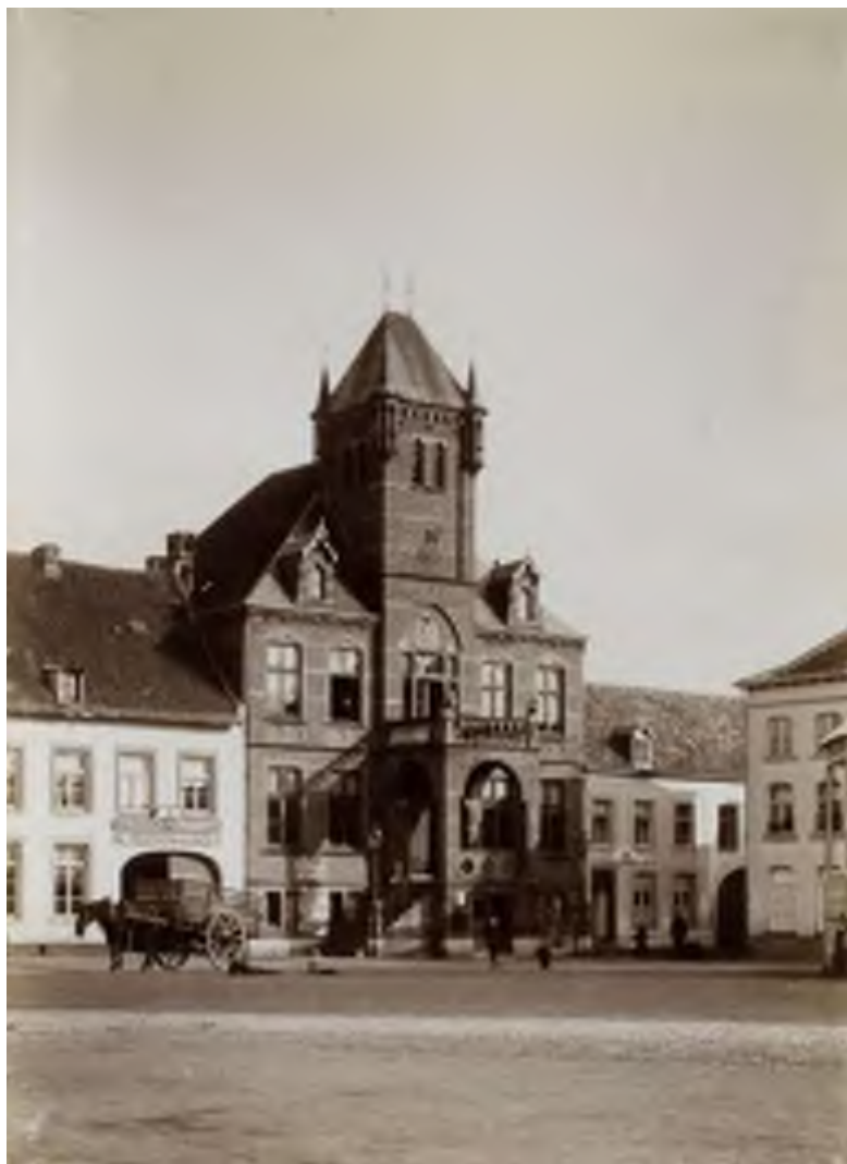
Voormalig stadhuis aan de Markt, datering ca. 1895 (bron: Archief De Domijnen, fotocollectie Jezuiten, identificatienummer 777-03-017). Op deze historische foto is de oude bebouwing te zien die rechts en links van het stadhuis stond.
