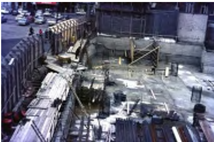
Bouwwerkzaamheden aan de nieuwbouw van Vroom en Dreesmann op de Markt te Sittard (bron: Archief De Domijnen, Collectie Gemeente Sittard, bestandsnaam diavgso04-07.jpg).
