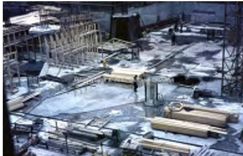
Bouwwerkzaamheden aan de nieuwbouw van Vroom en Dreesmann op de Markt te Sittard (bron: Archief De Domijnen, Collectie Gemeente Sittard, bestandsnaam diavgso04-08.jpg).
