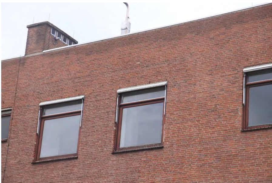
Foto 2: Ook aan de achterzijde van het gebouw zijn nergens geschikte broedplekken voor vogels met jaarrond beschermde nesten
