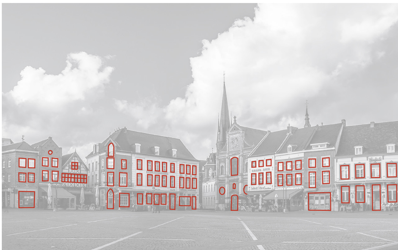
Gevelopeningen zijn veelal horizontaal en verticaal geplaatst in een stramien en de gevels landen op het maaiveld. Enkele bijzondere panden hebben een afwijkende gevelindeling.
