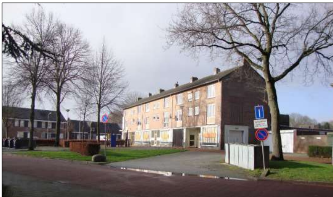
Portiekwoningen Bremstraat 2-22 (even huisnummers)
