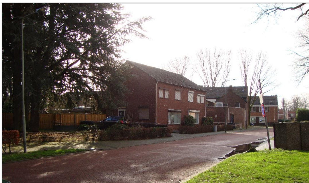
Twee-onder-één kapwoningen Bremstraat 1 en 3
