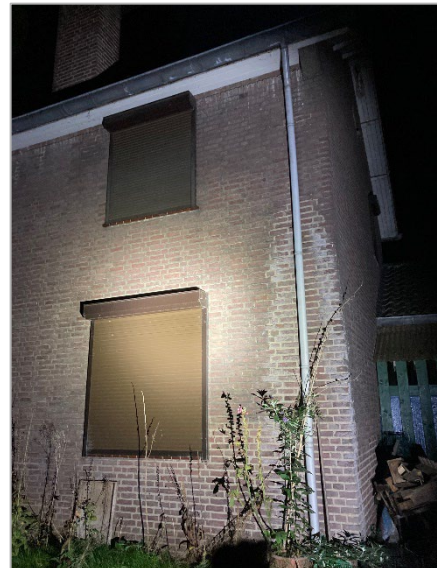
Figuur 7 Achtergevel Bremstraat 5, maatgevend immissiepunt voor raam op de eerste verdieping
