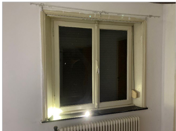
Figuur 9 Binnenzijde raam op de eerste verdieping, naar binnen draaiende raamvleugels
