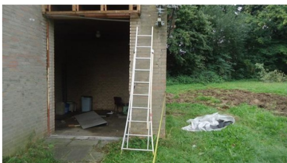
Foto 3: Toegang dak via ladder.
