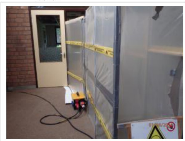
Foto 3: Containment en transitsluis
