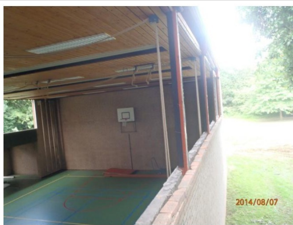
Foto 4: Kozijnen en katten verwijderd
