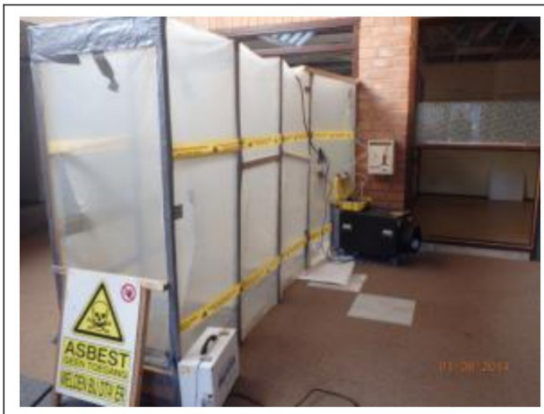
Foto 2: Transitsluis in gang opgesteld
