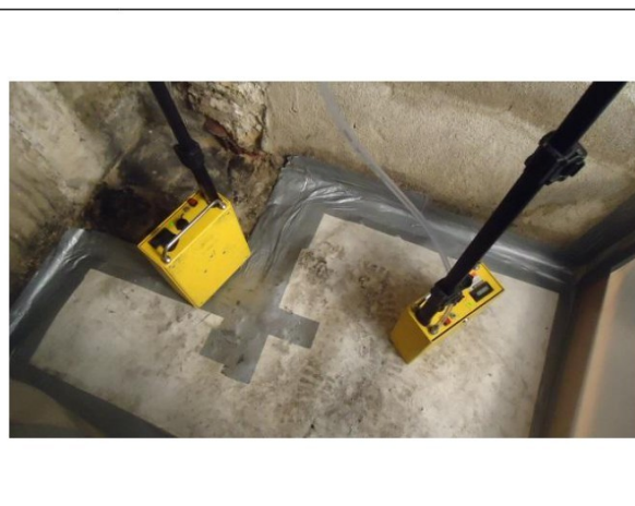
Foto 4: P116/K116 en P117/K117 in kelder.
