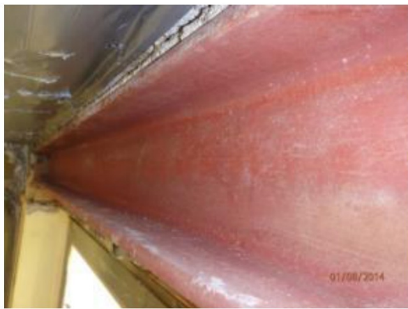
Foto 7: Plaats gesaneerde balkbekleding
