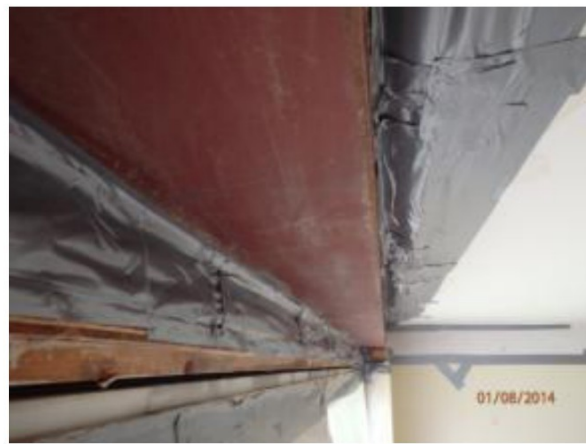
Foto 8: Plaats gesaneerde balkbekleding
