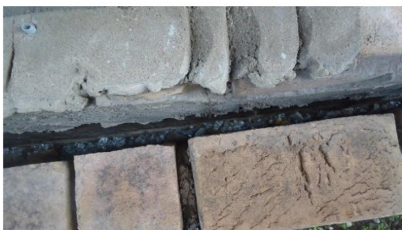
Foto 5: Spouwmuur beperkt inspecteerbaar.
