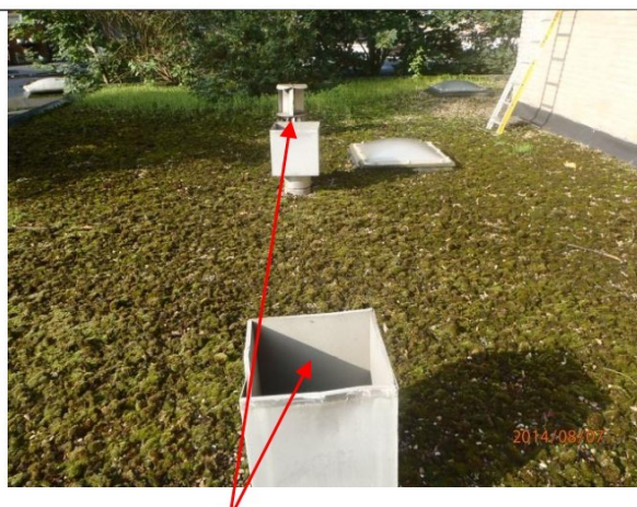
Foto 12: Afzuigventilatoren verwijderd
