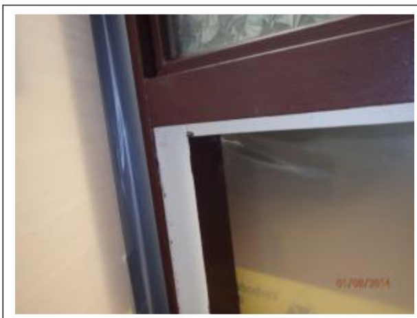
Foto 6: Plaats gesaneerde puivulling
