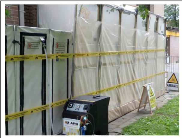
Foto 1: Overzicht containment buiten
