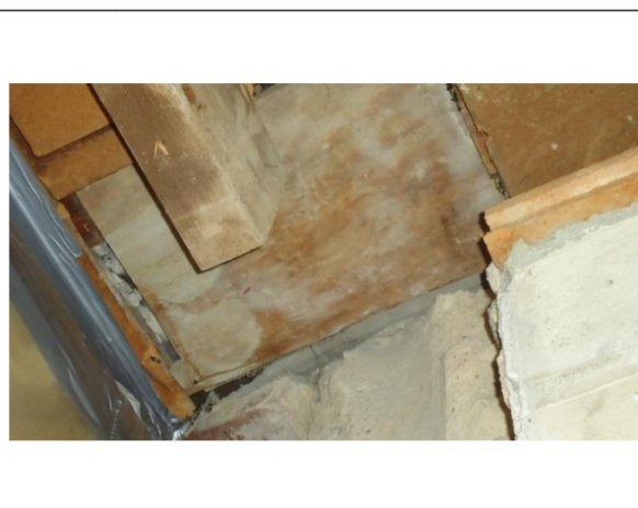
Foto 6: 1 e etage afgeschermd met houten plaatmateriaal.
