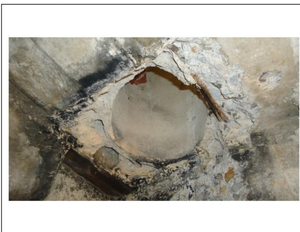
Foto 3: Doorvoer bg. Is schoon.
