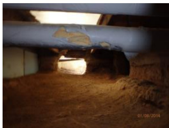
Foto 12: Gereinigd zandbed onder houten vloer lokaal 5
