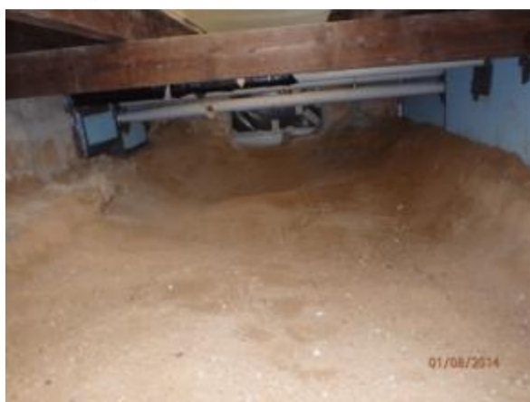
Foto 9: Gereinigd zandbed onder houten vloer lokaal 5
