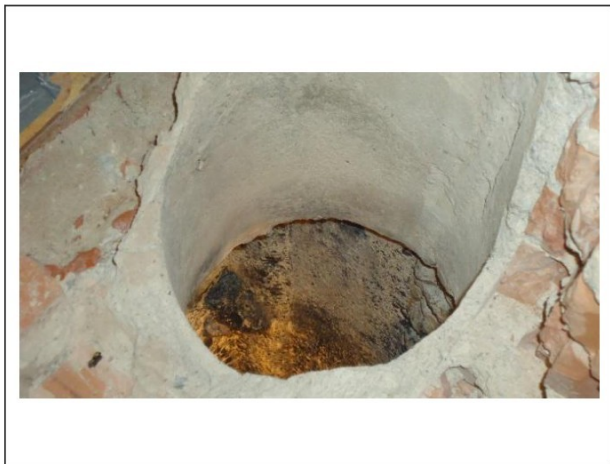
Foto 7: Doorvoer naar kelder is schoon.
