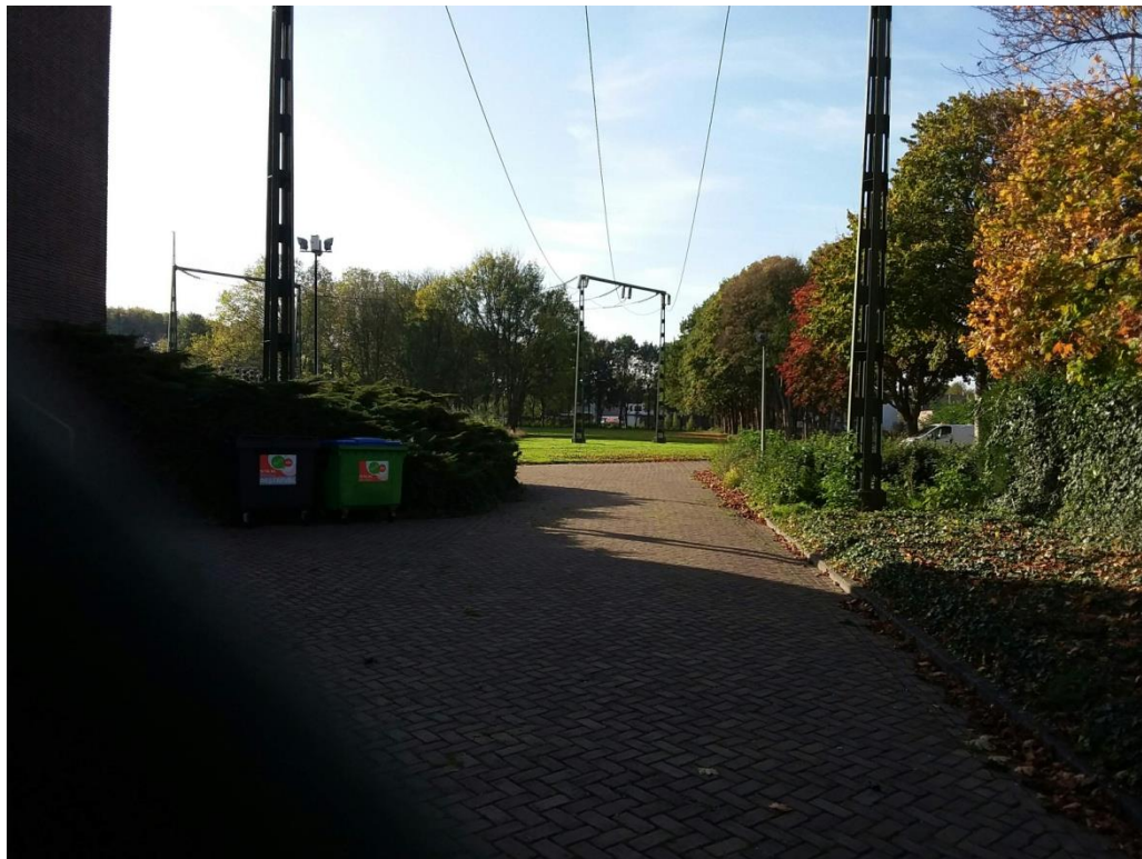
Foto 5: Werkterrein bij Tennet station aan de Valderenstraat. Grasveldje met struik vegetatie.
