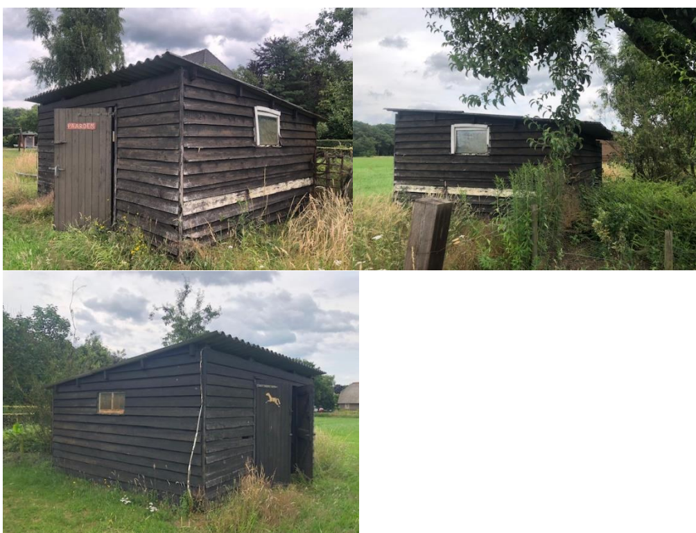
Afbeelding 3. Foto's buitenkant schuur, situatie op 30 juni 2023.
