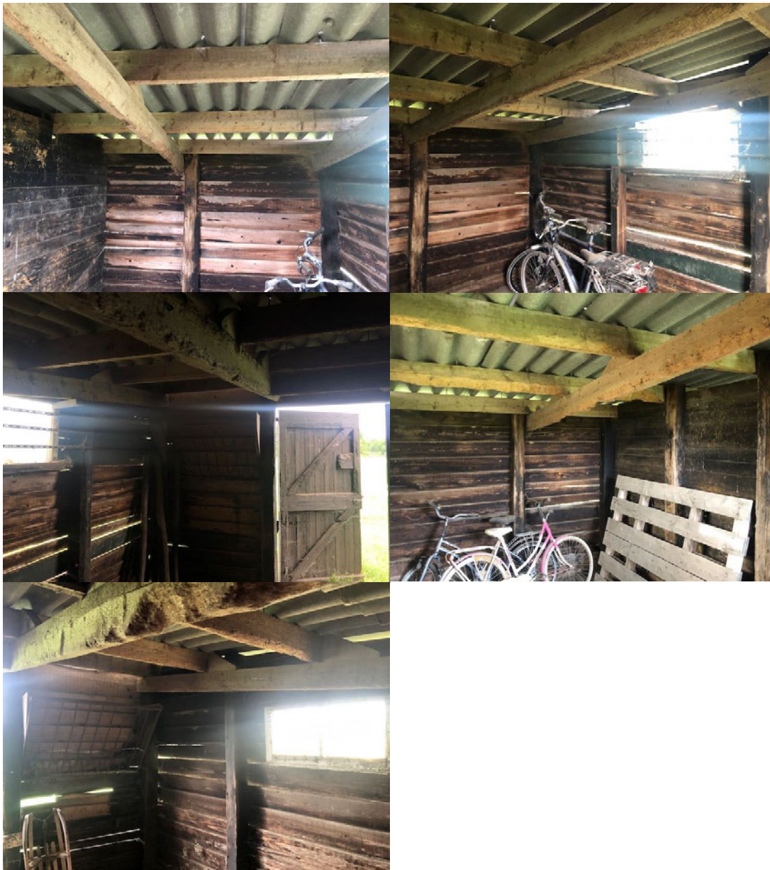
Afbeelding 4. Foto's binnenkant schuur, situatie op 30 juni 2023.
