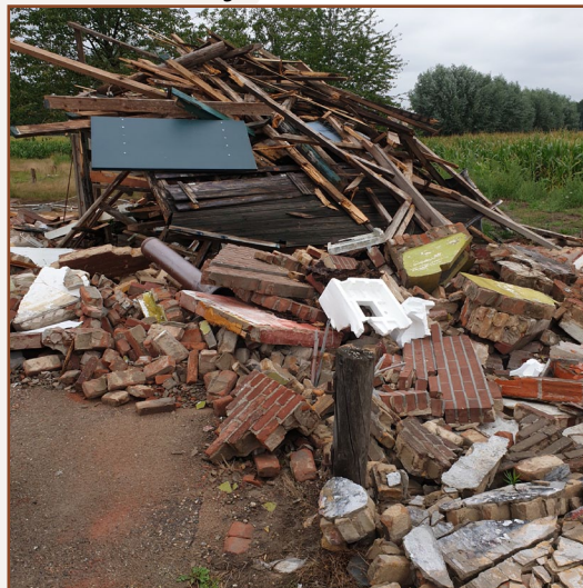
Afbeelding 9: Het wordt niet verwacht dat de puinstapels gebruikt worden door marterachtigen. Er is te veel verstoring aanwezig door de werkzaamheden.
