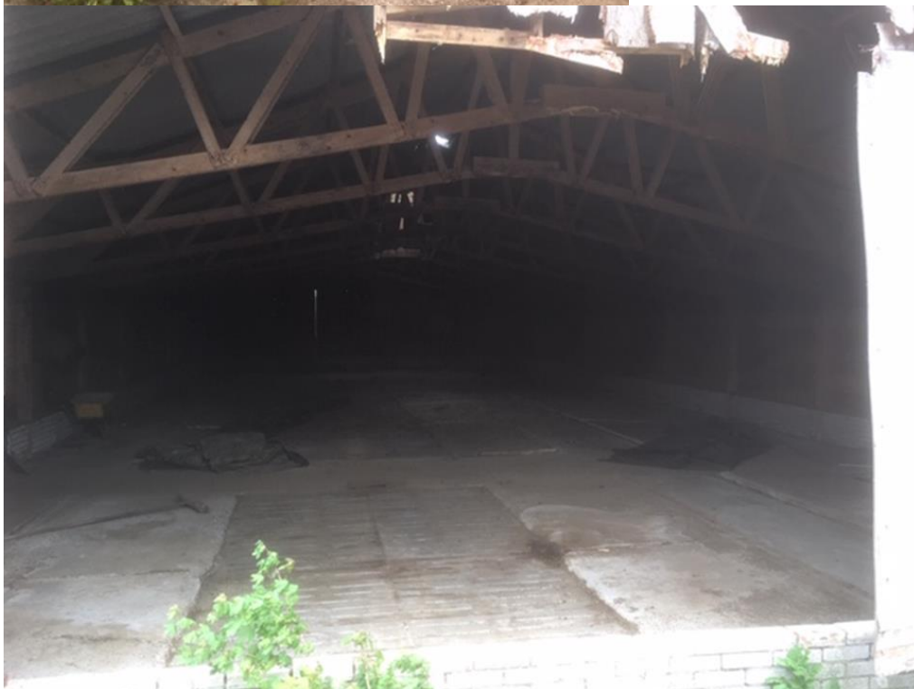
Te slopen varkensstallen
