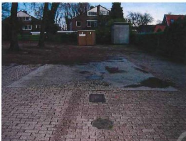
Wasplaats met olie-waterscheider
