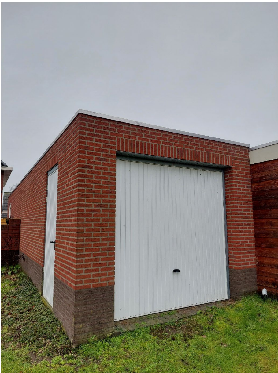
Afbeelding 5: de garage aan de zuidwestkant van het plangebied. Situatie op 10 maart 2023.
