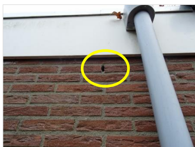
Figuur 5-6. Open stootvoeg gevel aan de westzijde.
