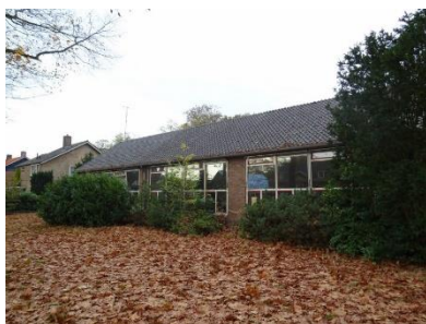
Figuur 2-3. Zuidzijde van bebouwing.
