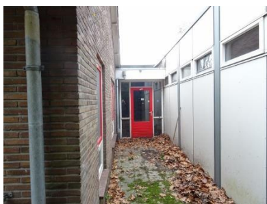
Figuur 2-6. Deur tussen oude bebouwing en uitbouw.
