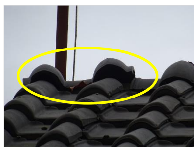
Figuur 5-3. Nokpan met kieren.
