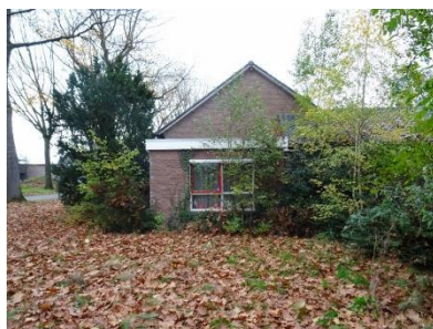
Figuur 2-4. Zuidoostzijde bebouwing.
