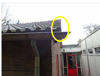
Figuur 5-1. Opening onder kant/eerste rij dakpannen.
