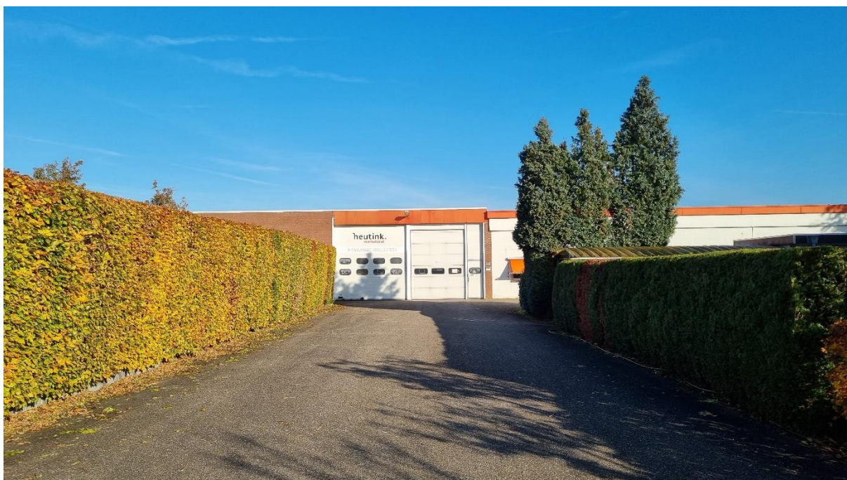
Foto 5: Achterzijde bedrijfspanden Heutinck
