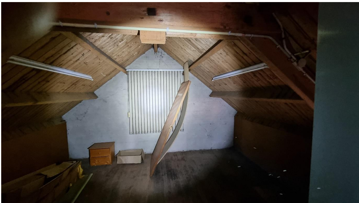
Foto 6: Zolder van de leegstaande bedrijfswoning.
