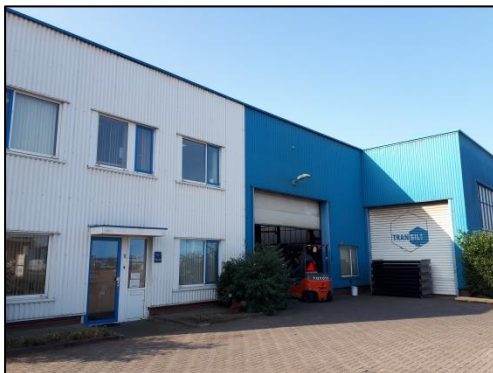
De loods foto genomen van de noordkant.
