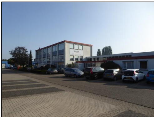
De loods opgetrokken uit metaal.
