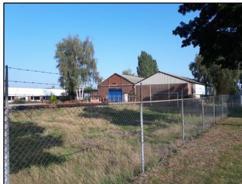
De loods welke deels is opgetrokken uit metaal en deels uit bakstenen.
