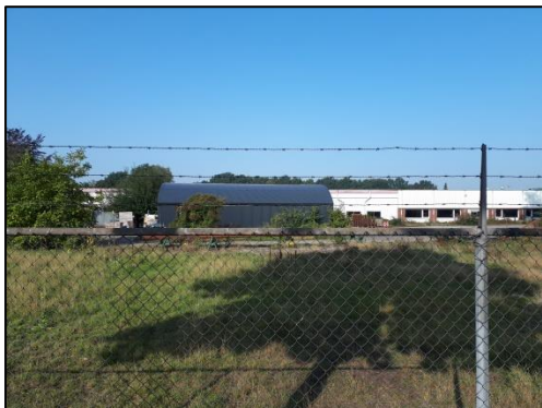
De loods opgetrokken uit metaal.
