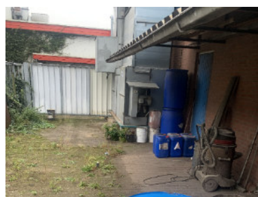
Buitenterrein, zuidzijde afzuiginstallatie en opslag onder afdak
