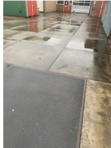
Buitenzijde vh pand (laad- en losgedeelte)
