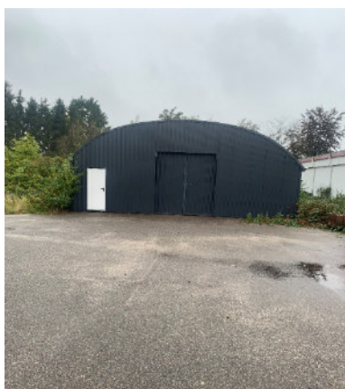
Achterste loods op het terrein
