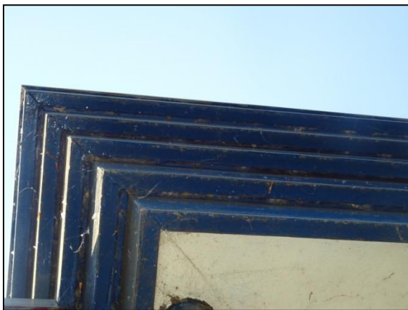
Figuur 10. Achter de gevelbetimmering is geen ruimte aanwezig die geschikt is als verblijfplaats voor vleermuizen.
