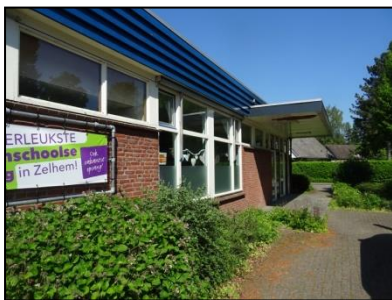
Figuur 3. Westgevel van de bebouwing.
