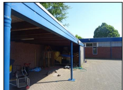
Figuur 5. Binnenzijde van de overkapte berging aan de oostzijde.
