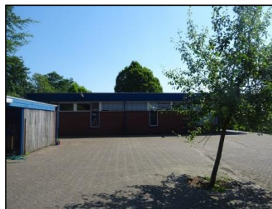
Figuur 4. Oostzijde van de onderzoekslocatie.
