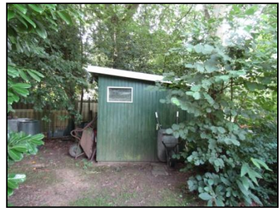
Figuur 5. Oostelijke houten schuur.
