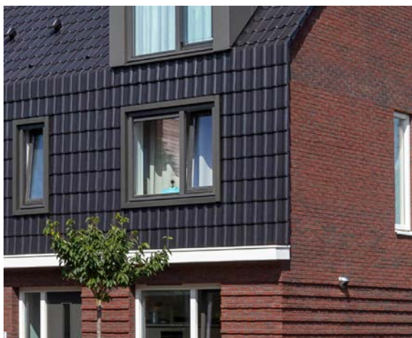
Voorbeelden van dakbedekking die doorgetrokken is over de gevel op de eerste verdieping, waarbij ondanks en lage goot toch een volledig woonprogramma op de eerste verdieping mogelijk is.
