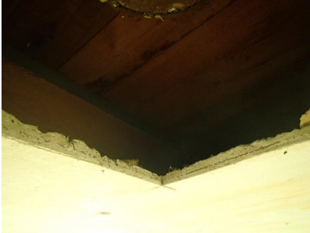
Foto 7: links, ruimte in plafond zolder zuivelfabriek.
