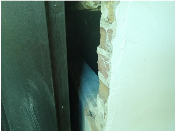
Foto 9: links, ruimte achter de muur begane grond zuivelfabriek.
