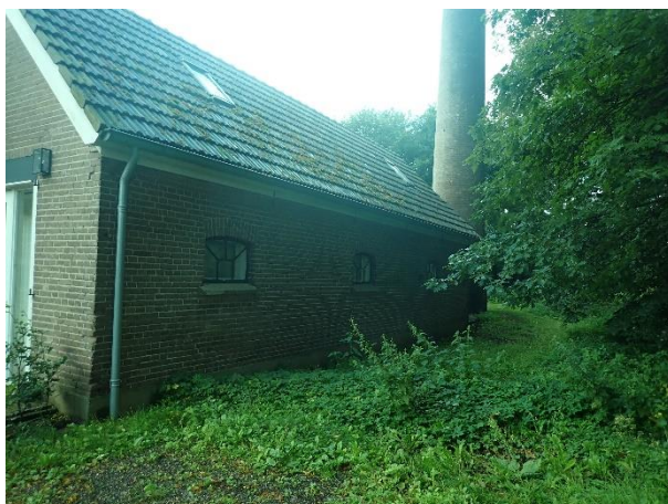
Foto 17: links, zijkant zuid stalgebouw.
