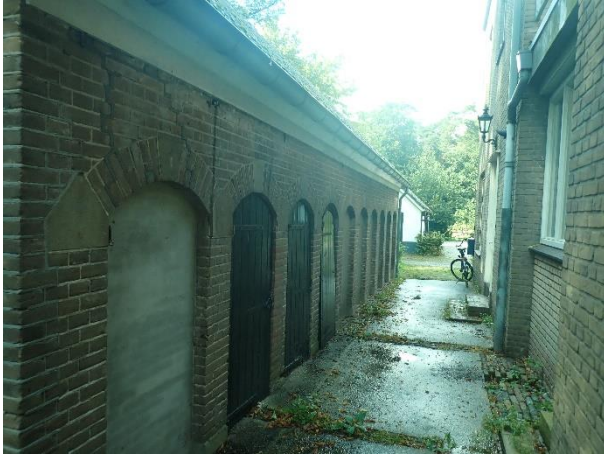
Foto 13: links, zijkant noord stalgebouw.
