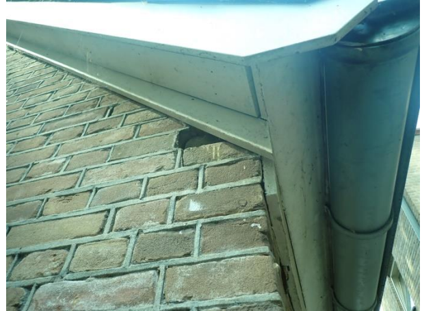
Foto 14: rechts, openingen bij dakrand zijkant (en deels achterkant) noord stalgebouw.
