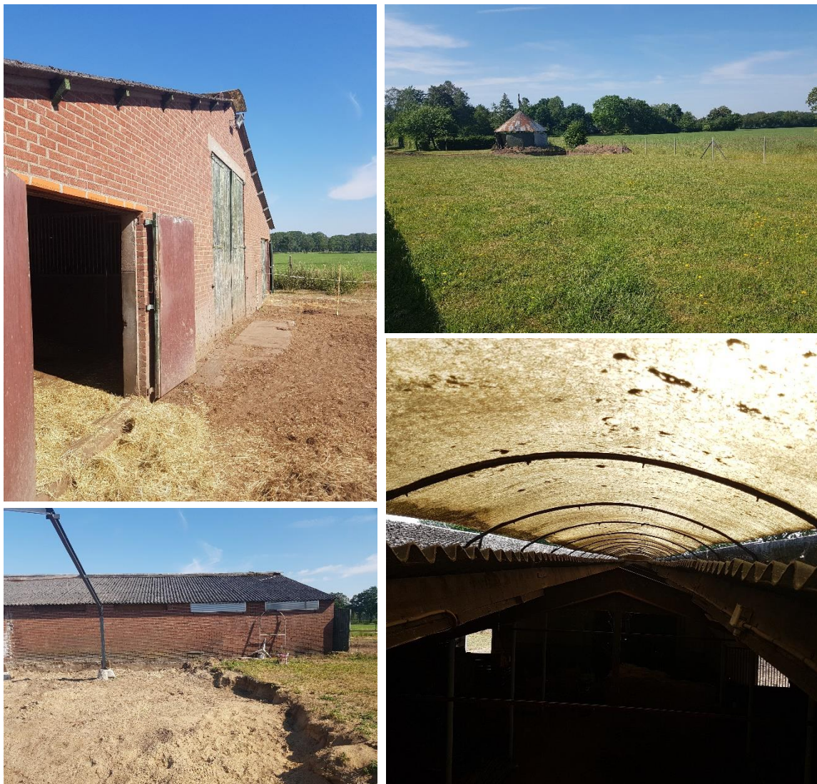
Figuur 2. Gevel aan de westkant van de te slopen stal (linksboven), grasveld waar een kleine stal wordt gerealiseerd (rechtsboven), zuidzijde van de stal (linksonder) en de kunststof nokvorst van de stal (rechtsonder).
