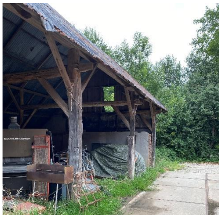
Figuur 4: Te behouden en renoveren kapschuur met 3 vakken oude gebinten – Te slopen vervallen bijgebouwen op achterterf.
