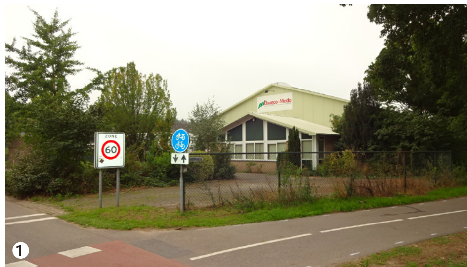
Entree kantoor, zichtlocatie vanuit de provinciale weg en sierbeplanting voorzijde
